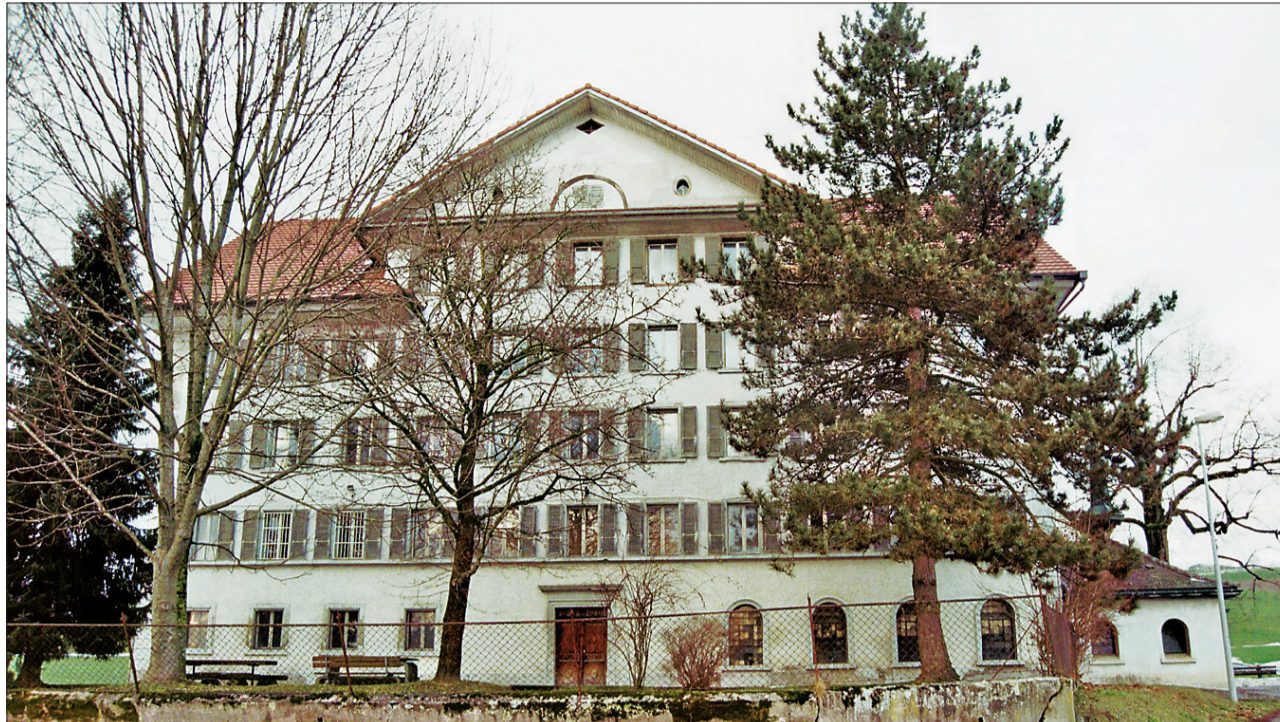
Das ehemalige Bürgerheim Rüt matt wird derzeit als «Kopie» wieder aufgebaut – dies ist beim Chrämerhus von Gesetzes wegen nicht möglich. Fotos zVg
