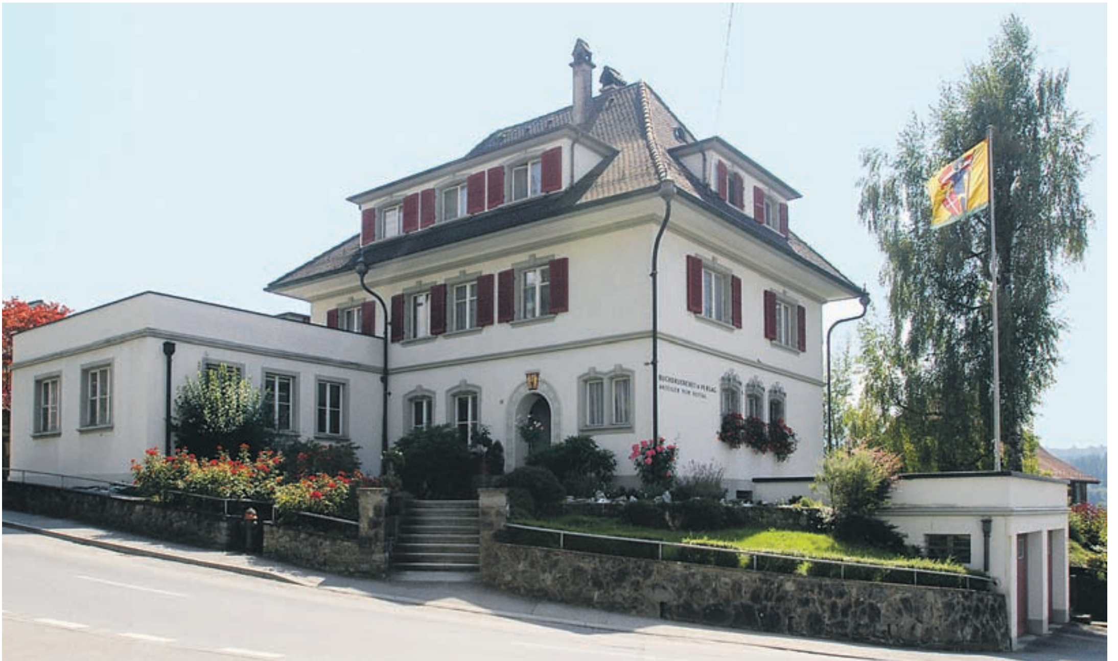
Das Druckereigebäude zum Gutenberg (Neuenkirchstrasse 14) wurde 1933 von Adolf Meyer-Häfliger erbaut und 1972 von Sohn Adolf Meyer-Stürmimann in östlicher Richtung erweitert. Foto Erwin Ottiger
