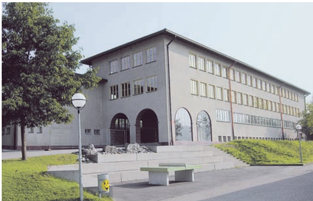
Das 2004/05 erstmals grundlegend renovierte Meili-Schulhaus auf dem Kalofen. Foto Adolf Bühler
